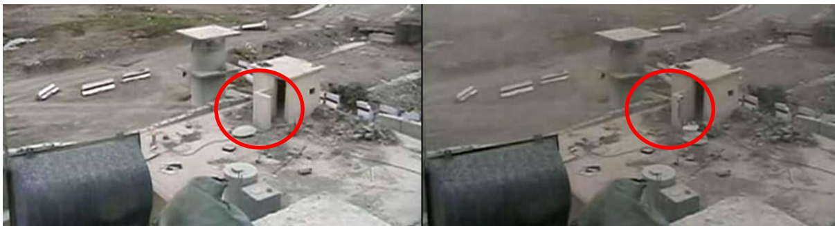
30. ábra - Támaszponti épület előfalának leomlása a robbanás következtében (63) - Irak
