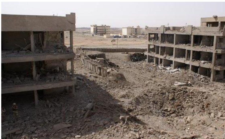
29. ábra - Robbantás után állva maradt vasbeton épületek - Irak
