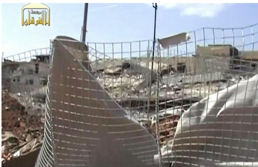
28. ábra – Tönkrement HESCO bástyák robbantás után – Irak
